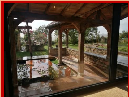
Restauration de l'ancienne porcherie Atelier du Cloître & jardin japonais (en cours d'aménagement)
